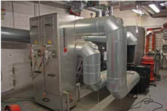
Hackschnitzelkessel mit Hochvoltabscheider für Feinstaub
