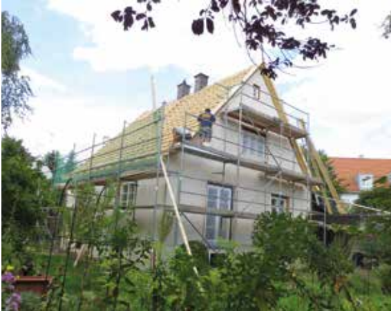
Einfamilienhaus in Markt Indersdorf, bei dem durch Dämmung von Dach und Wänden die Behaglichkeit deutlich gesteigert und der Energiebedarf halbiert wurde
