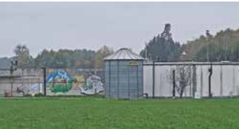
Die Biogasanlage mit Gärbehälter (rechts) und Gärrest-Behälter (links)
