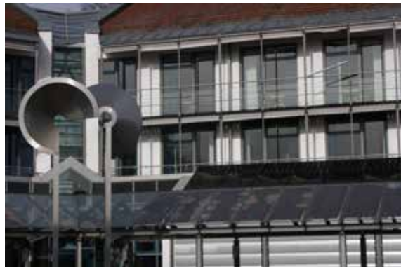
Die Photovoltaikmodule auf den Kolonnaden (vorne, außer Betrieb) und als Verschattungselemente (hinten, neu)
